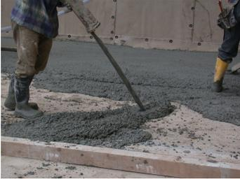
Formazione di una cappa in calcestruzzo avente lo stesso RcK della successiva platea, per uno spessore  $\geq 5$ cm quale protezione del sistema impermeabilizzante. Tale cappa potrà essere omessa su indicazione della D.I.
